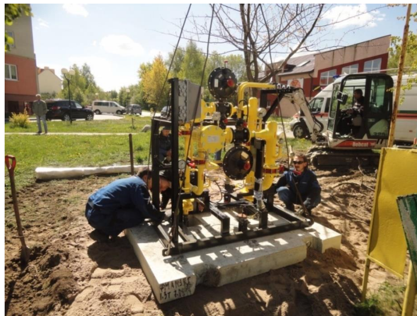
8. Зафиксировали установку анкерами по бетону к фундаментной плите
