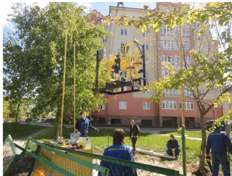
7. Смонтировали ГРУ на раме на фундаментную плиту, сболтили фланцы входного и выходного патрубка с патрубками ГРУ
