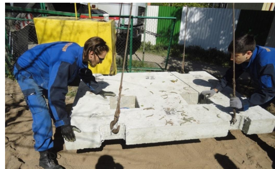
6. Установили предварительно изготовленную фундаментную плиту или залили её на месте, предварительно смонтировав опалубку
